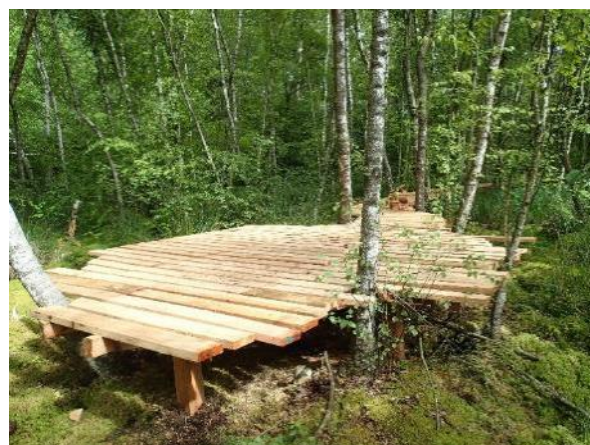
Photographie 15 : Plateforme d'accueil en construction
