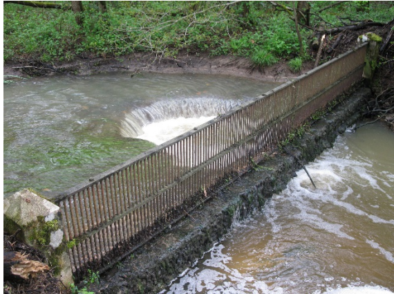
Photographie 8 : Ouvrage hydraulique sur l'étang Fouget
