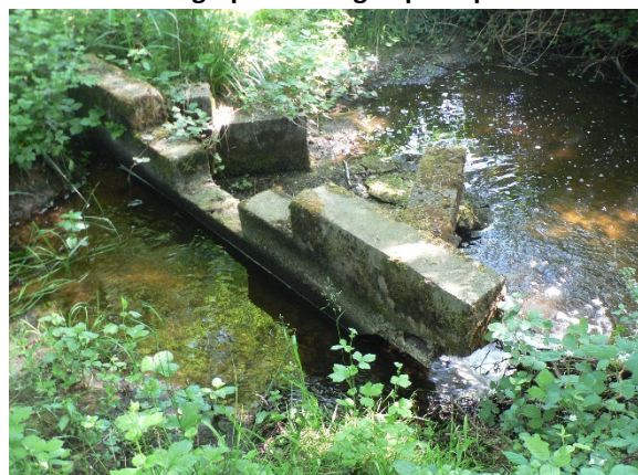
Photographie 11 : Exutoire est
