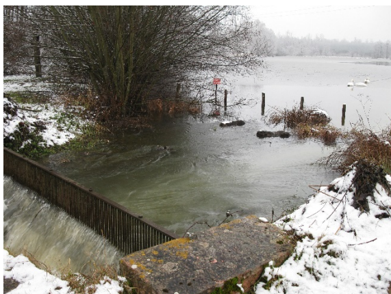
Photographie 10 : Exutoire sud
