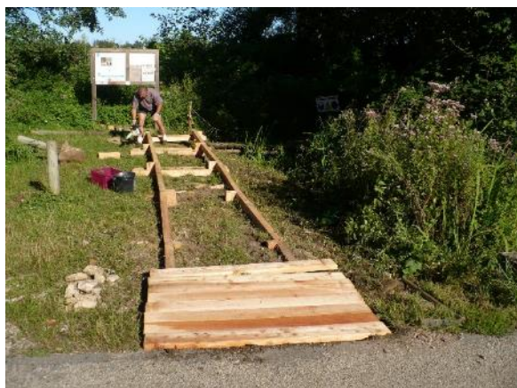
Photographie 12 : Installation du pilotis en 2012
