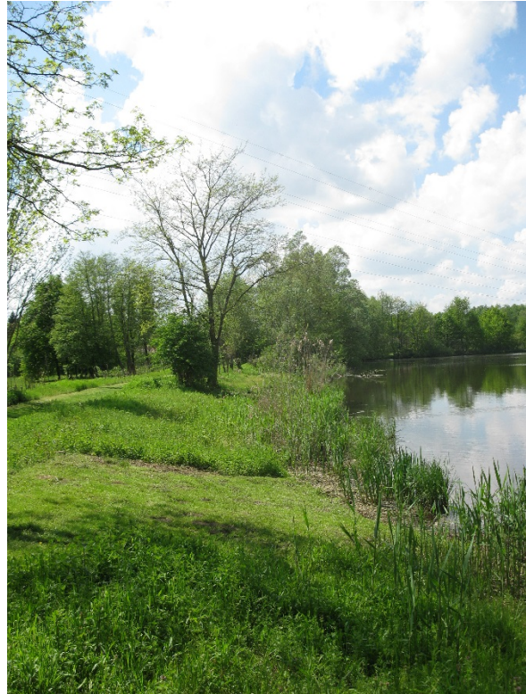
Photographie 9 : Digue principale
